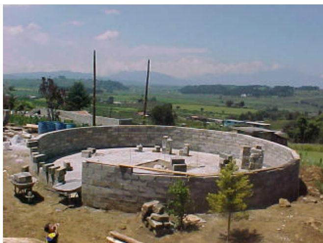
Construcción del temazcal más grande de Mesoamérica. Xalatlaco, Estado de México
